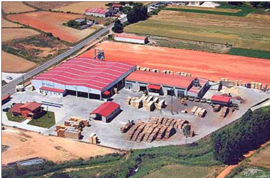
Instalaciones de Ribsa en las que se ubicará la planta de producción de pellets que será líder en España. / ECB
