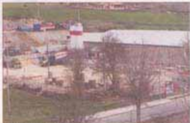
Las obras marchan a buen ritmo. / E.L.
